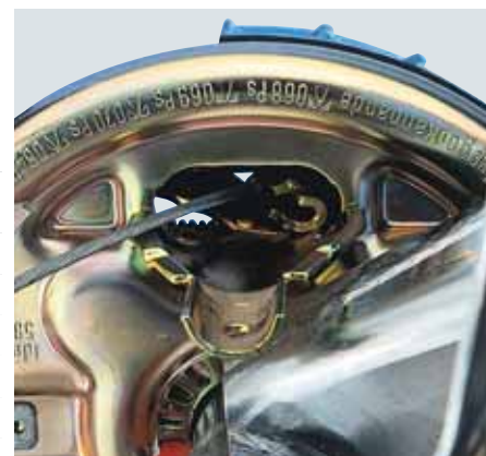
Монтаж тормозного троса в колесном тормозе
